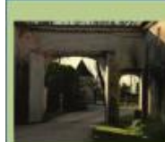
F - Fuite de La Quantinerie
