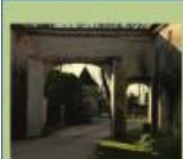
F - Fuite de La Quantinerie
